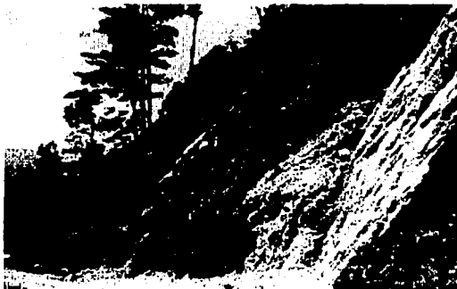
Figura 3.3 Deslizamientos originados por cortes para la construcción de caminos en laderas muy inclinadas de rocas calizas, en las que los estratos se hallan orientados a favor de la pendiente e inclinaciones de más de 45°.
