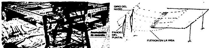
Fig. IV.21. Acumulación de concreto y efectos
