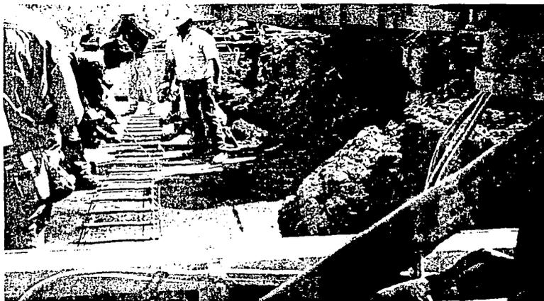
FIGURA V.9 PASAJUNTAS MONTADAS EN SILLETAS PARA EVITAR QUE DESPLACEN EL COLADO.
