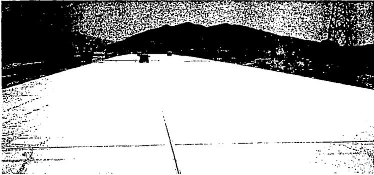
FIGURA V. 7 ASPECTO DE LAS JUNTAS LONGITUDINALES Y TRANSVERSALES.
