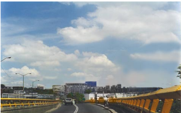
Periferico tramo san antonio sin espectaculares
