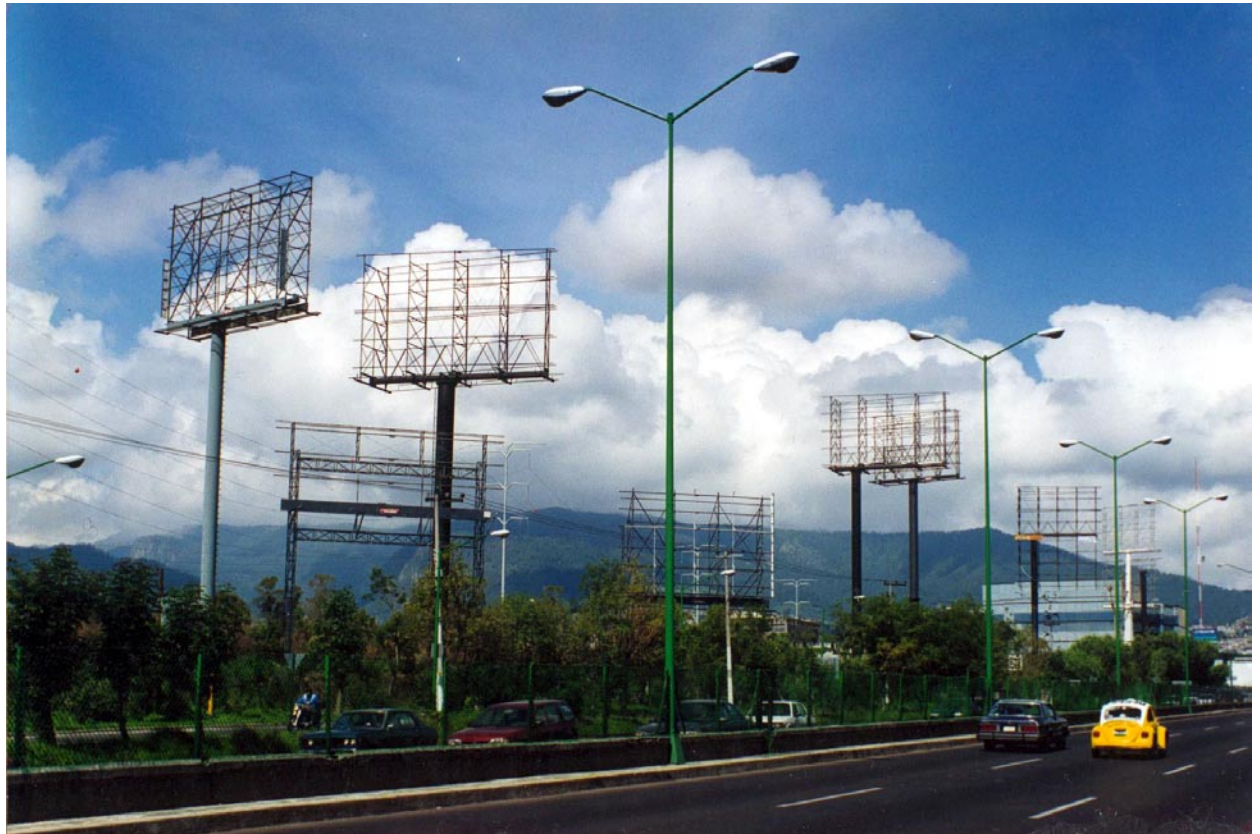
Periferico tramo ajusco estructuras reciclables
