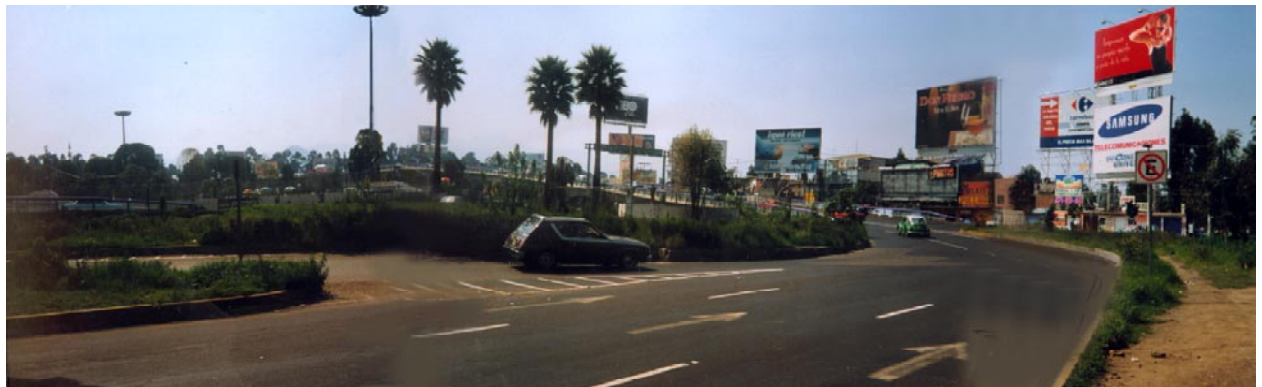
area de intervencion clorieta vaqueritos
