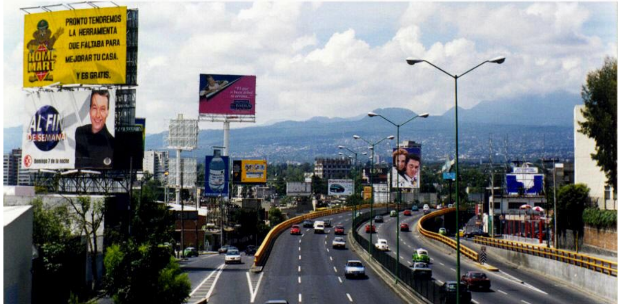
Periferico tramo de avenida Toluca
