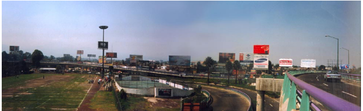
area de intervencion clorieta vaqueritos
