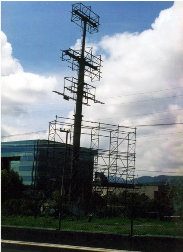
Periferico tramo ajusco estructuras reciclables
