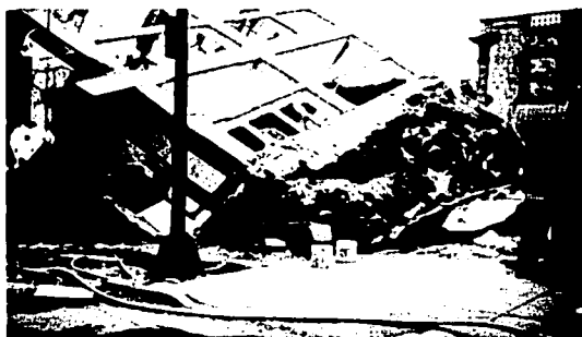
Figura 2.5 Colapso de un edificio en cd. de México en el sismo del 19 de septiembre de 1985
