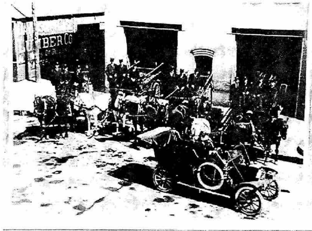
Exterior de una estación de bomberos con las bombas y carros de tracción animal. *firex.es/links.html
