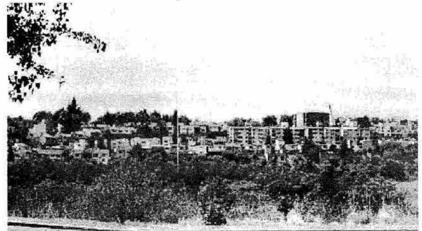
*Vista hacia el poniente desde el terreno.
