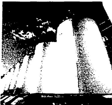
Foto I.4.- Reforzamiento de silos con productos de polímero reforzado (Sika)
