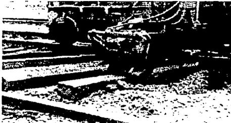
Foto IV.4.- Instalación de durmientes de plástico con equipo mecánico. Línea Union Pacific Railroad (Lousiana, EUA).
