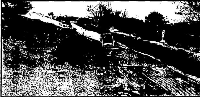
FIGURA 5.22 "TENDIDO DE LA ARENA TÉRMICA CON EL MINICARGADOR
