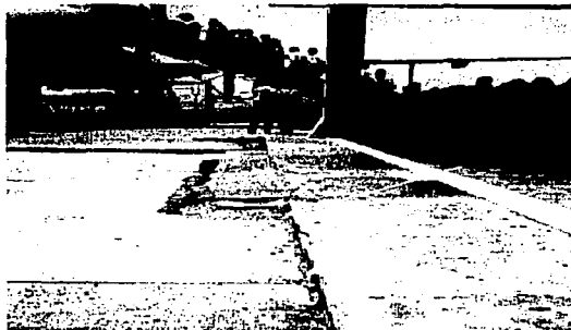
Fig.11: La reparación de esas grietas es esencial para evitar la penetración de agua o de anticongelante en su base o en el terreno de fundación, sin embargo, no es posible adherir firmemente las partes quebradas ni conservar la estabilidad del pavimento, foto cortesía de Aeroméxico.
