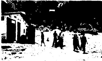
19. Área de servicios y sanitarios
