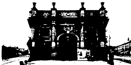
Pórtico entrada principal a las Casas de Mier y Celis. Ave. Jalisco y Ave. Revolución.
