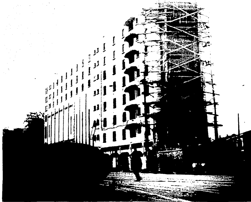
Fotografía de los terminados de la Fachada Norte del edificio Ermita
