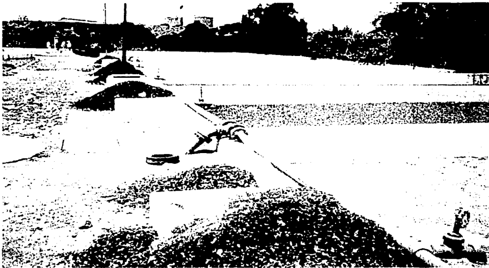
Lechos de secado de lodos
