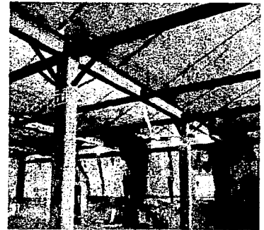
Elementos estructurales que por su fatiga han sido reforzados.
