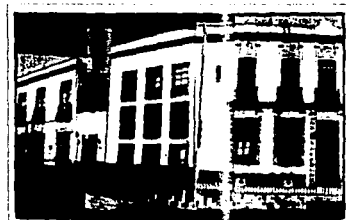
Conjunto Habitacional de la reconstrucción
