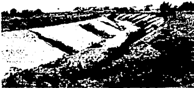
"Rio Guanajuato" tramo con recubrimiento de geotextil Km 10+799-Km 11+300
