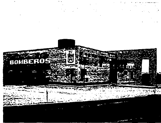
Fachada principal de la Estación de Bomberos de Aguascalientes.
