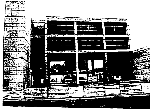
Fachada principal de la Central de Bomberos de la Delegación Iztapalapa.
