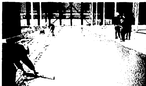
Fig. 6.3-6 Flota denominada "Bump Cutter", para cortar puntos altos y rellenar los puntos bajos del concreto.
