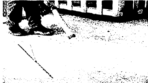
b) Aplicación con pistola sellador epóxico
