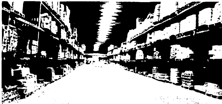
Fig. 1.2-1 Bodega con altas especificaciones técnicas en un piso industrial
