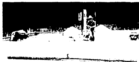
Fig. 6.3-6 Flota denominada "Bump Cutter", para cortar puntos altos y rellenar los puntos bajos del concreto.
