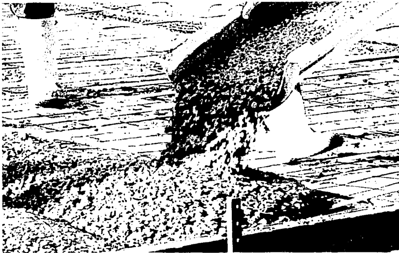
Fig. 2.2-3 Ilustración de un inadecuado diseño de mezcla del concreto, debido a la ausencia del agregado fino.
