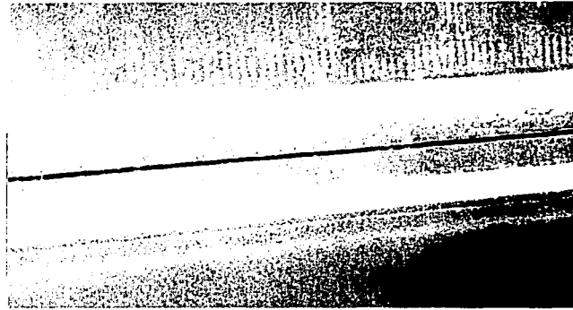
Fig. 5.11-1 Corte empleando equipos de corte temprano y vista del corte temprano realizado en seco.
