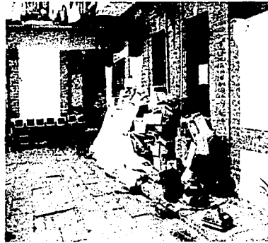
Fig. 12. Vivienda usada como bodega en la calle de Echeveste.
