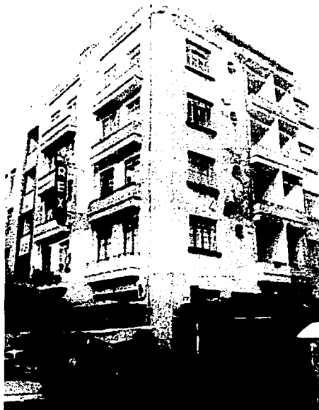
Fig.36. Edificio de departamentos de mediados del siglo pasado en la calle de Aynamiento.
