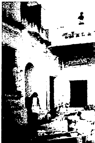
Fig.42. Vecindad del centro, antes de ser restaurada.
