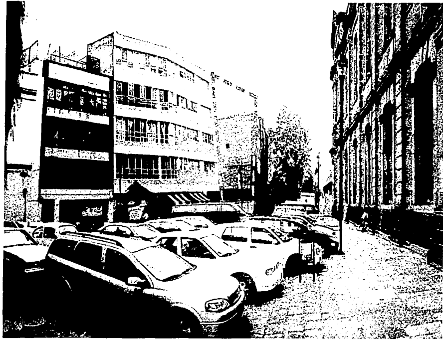
Fig. 62. Vista de el terreno de la plaza regina.
