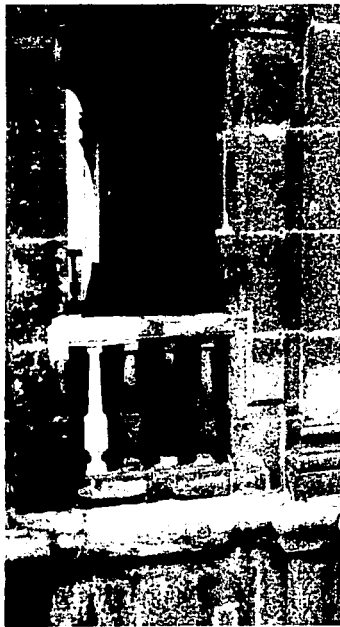
Fig.25. Desfiguración de una fachada producido por el guano de paloma.
