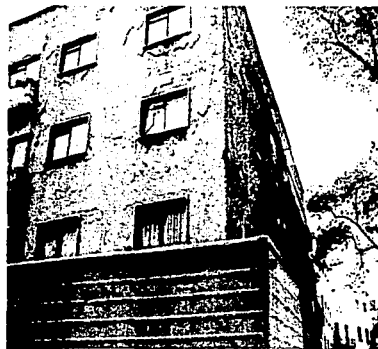
Fig.16. Edificio en deterioro, por renta congelada.
