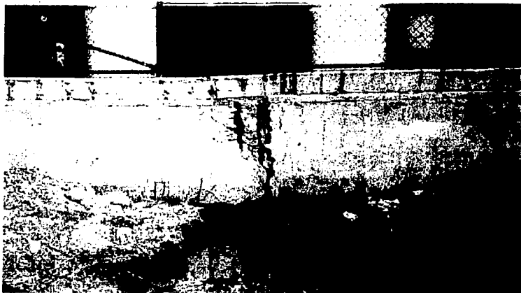
Figura 2.10. Agrietamiento en muro sur del cajón superficial, cadenamiento 17+020.
