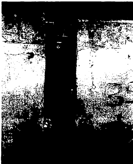
Figura 2.14. Junta de expansión con abertura de 20.7 centímetros, cadenamamiento 17+191.315.
