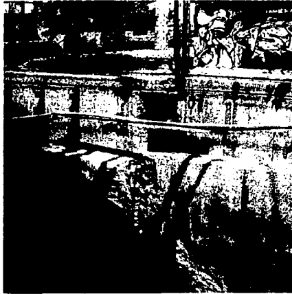
Figura 2.32. Falla de junta de expansión sobre el muro central y norte del cajón superficial, cadenamiento 22+455.
