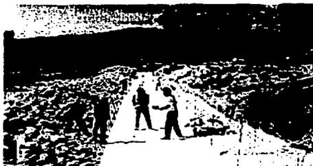
Fig. V.4.6 Formación de los gaviones para iniciar el relleno
