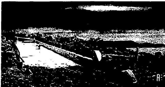
**Fig. V.8.1.1 Corte de las mallas seg n la altura del muro**
