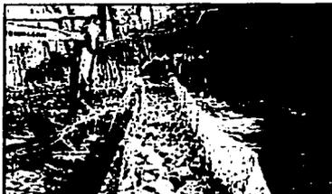
Fig. 1.4.2 Malla de alambre galvanizado o gavión relleno de piedras.
