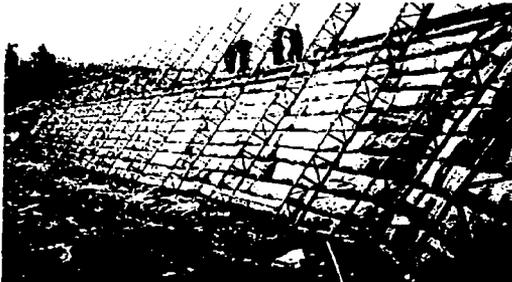
**Fig. III.1.1.3 Muro apoyado en un andamiaje externo como apoyo para evitar el colapso de la obra**
