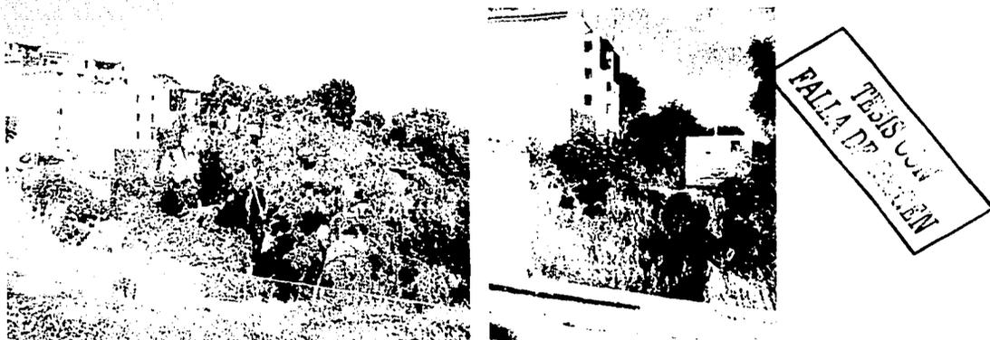
Figura 4.6 Imágenes de la unidad habitacional La Concordia, cuya ubicación cercana a un barranco, con un circo de erosión activo, constituido de tobas no consolidadas y pendientes de más de 50°, le confiere un riesgo a primera vista evidente, que se corrobora con el movimiento de la ladera oeste del barranco la mañana del 5 de octubre de 1999.
