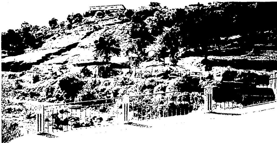
Figura 6.12 en la imagen se distingue el cuerpo de un movimiento avanzado de reptación, que puede convertirse en deslizamiento, a la orilla del libramiento oriente, cerca del río Texpilco. La zona es de nivel de riesgo medio a alto. Aquí el factor principal de inestabilidad de la ladera es la construcción de la carretera, y en menor grado la deforestación del área.
