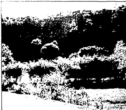
Figura 6.8 Corte vertical al poniente de la localidad, en cuya cabecera se asientan viviendas. El índice de estabilidad muestra dicha pared como de alto peligro, debido a la pendiente. Sin embargo, el material es resistente y sólo se observan en campo algunos desprendimientos menores. En la parte baja se encuentran acumulaciones de material removido por caída libre (detritos). En la terraza fluvial se observan bloques, probablemente desprendidos de la misma ladera.
