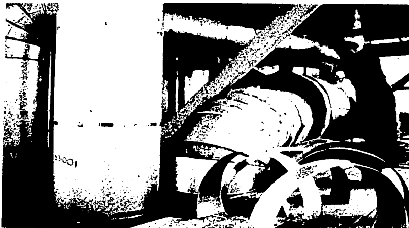
Fig. 2.3 Acero aluminizado utilizado como envoltura para aislar tuberías en una refinería de petróleo.
