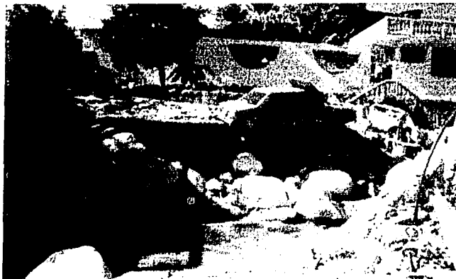
Foto 1. Bloques de roca arrastrados por la corriente del Camarón. Se puede observar la destrucción de las banquetas y la calle.
