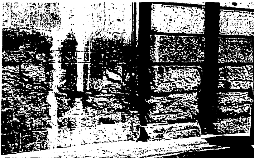
Fig. 14. Disgregación
