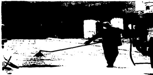
Fotografía 12 "Riego asfáltico, a pie, de las vialidades del Fraccionamiento
