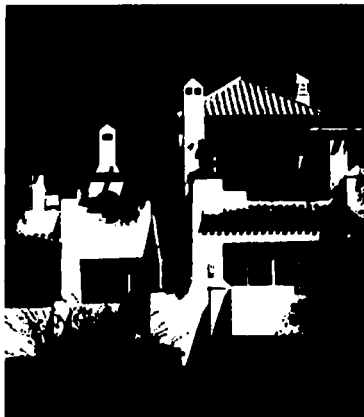
Techos inclinados recubiertos de teja.
