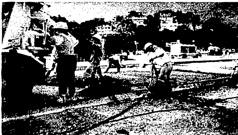
Figura V.11 Fotografía de colocación de concreto en el piso del Portal del túnel a la caseta de peaje
