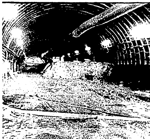
Figura III.120 Fotografía de excavación en la media sección inferior del túnel (banqueo)
