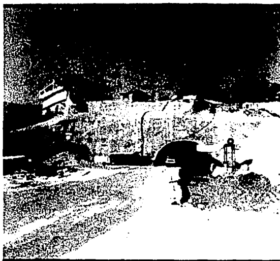
Figura III.118 Fotografía de excavación en la media sección inferior del túnel (banqueo)
