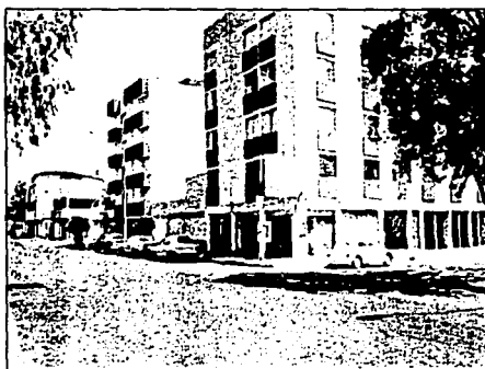
EDIFICIOS DE OFICINAS Y LOCALES COMERCIALES AL ORIENTE DEL PREDIO
