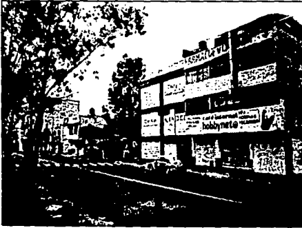
CENTROS ESCOLARES UBICADOS EN BLVR. DEL TEMOLUCO
