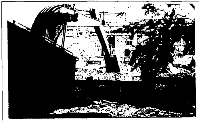
Trabajos de demolición
