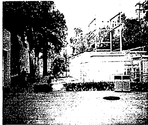
Fig. 81. Andador frontal (de acceso), desde el Edificio Central
