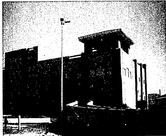
Figura 3. Vista Parcial de la Fachada Oeste del H.I.C.
