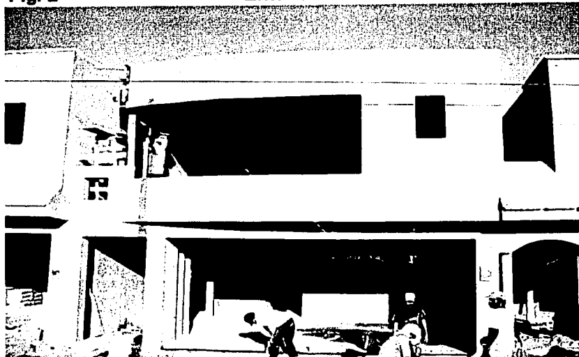
Fachada con pocas líneas y elementos
