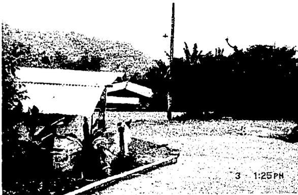
Fig. 86 Vivienda rural actual, en la zona de Córdoba, Ver. Construidas algunas con laminas de cartón, o laminas galvanizada, para las techumbres y muros de tabloncitos de madera, cuando pueden mejoraría cambiar la madera por block de tepezil, las techumbres siempre son a dos aguas.
