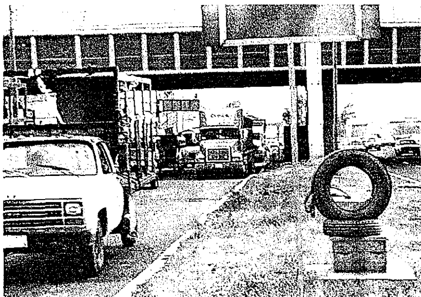
Fig. 4.8 Tránsito pesado que circula sobre el cajón de cimentación
