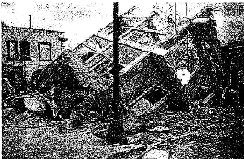
Fig. 1.1 Colapso total por volcamiento de un edificio cimentado con pilotes de fricción (Mendoza, 1987)
