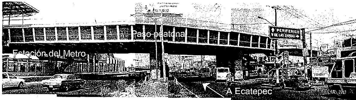
Fig. 4.1 Vista actual del apoyo No. 6 del puente vehicular Impulsora
