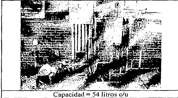
Figura 3.39 Depósito diesel
