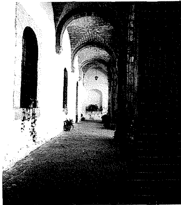
Fig. 75. Interior del claustro de Nuestra Señora de la Soledad, Valladolid (hoy Morelia), México.
