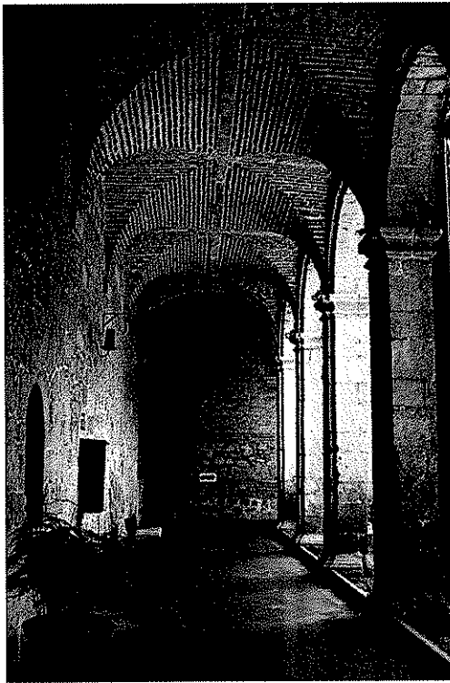
Fig. 68. Interior del claustro de San Joaquín con bóveda arista, Tacuba, México, D.F. Fotografía A.S.
