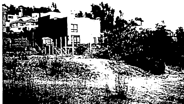
vista 5 construcción colindancia oriente
