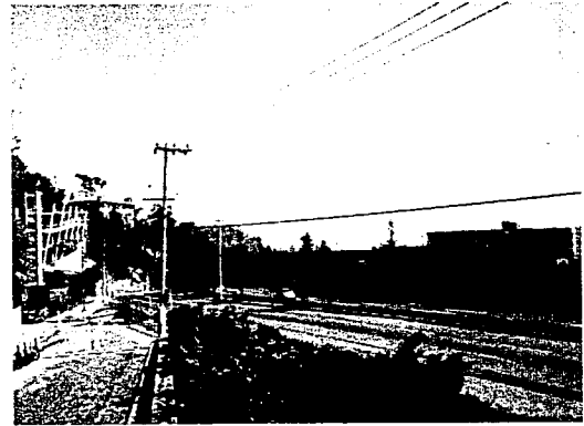
Vista Prolongación Paseo de la Reforma
