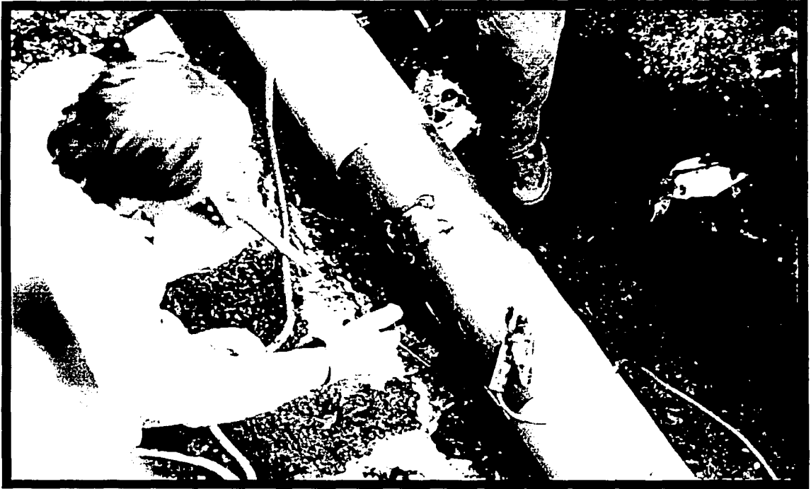
FIG. 4.10 REPARACIÓN DE CABLE DAÑADO
