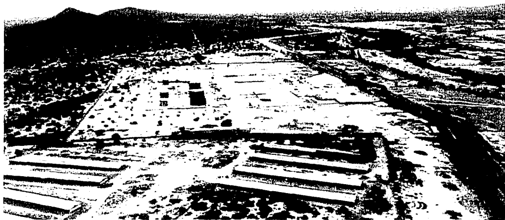
Nueva instalación, ubicada en zona industrial alejada del centro de población.
