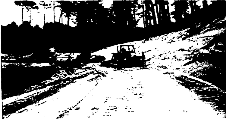
Foto 5, Formación de terraplenes.
