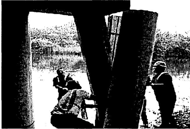
Figura 3.18 Encamisado con FRP de una columna
