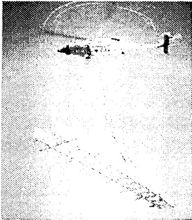
Figura 3.8 Instalación por Helicóptero de un puente de 21.5 metros de claro
