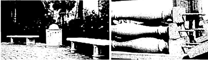
Figura 3.34 Elementos arquitectónicos prefabricados con barras FRP
