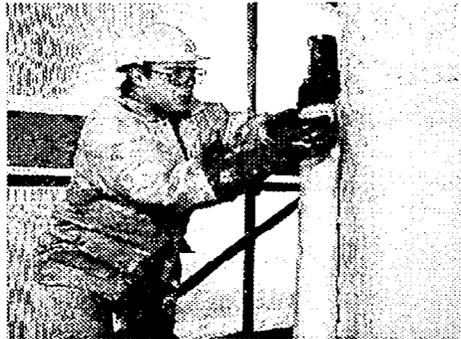
Figura 3.15 Aplicación de la lámina FRP
