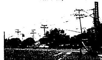
Derecho de vía del tren ligero
