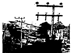
Red de electrificación aérea
