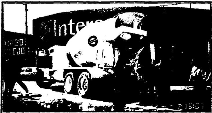
Camión revolvedor descarga en un tanque abandonado de lo que fue una gasolinera.
