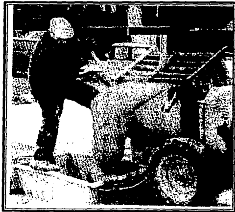
El mortero debe fluir fácilmente de la revolverta.
