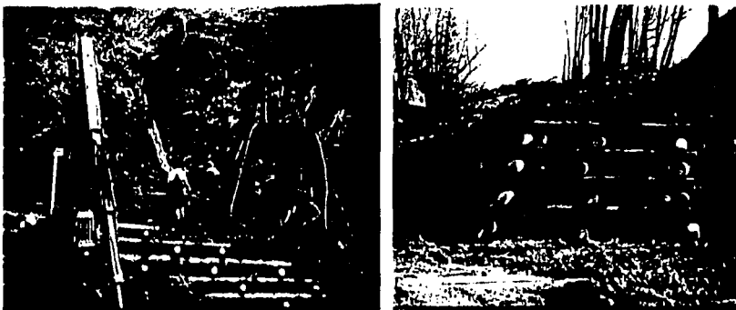
Figuras 22 y 23: Ejemplos de construcción de pared "Krainer"
