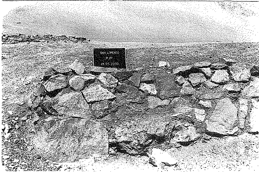
FIGURA 38. SAN LORENZO, MAMPOSTERIA DE CIMIENTOS GRUESOS, PIRCADO Y SOLUCION DE ESQUINAS. MODELO EN RECINTO 27.
