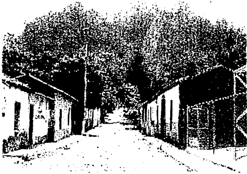
A.-Perspectiva del conjunto de casas que están siendo catalogadas como patrimonio arquitectónico, entre éstas hay 3 que están desocupadas y pueden ser utilizadas. Conservan su estructura y patios huertos típicos.
