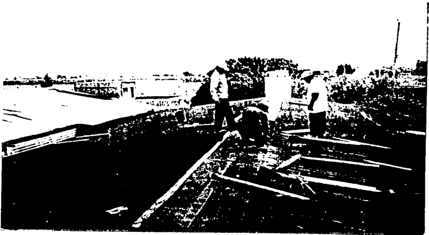
Fig. 5.23 Impermeabilización de escuelas
