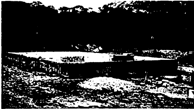
Figura 5.8 Colado de tapa en biodigestor
