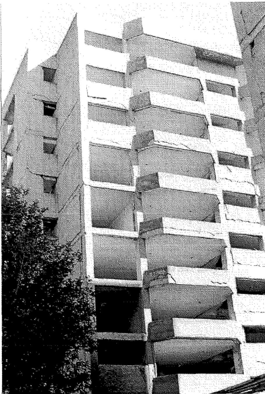
Foto 4. Edificio ubicado en la calle Paseo del Rfo #298 afectado por los sismos de 1985.
