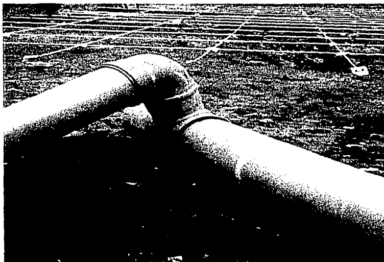
Fotografia no. 9 Silleta W montada en la atarjea, unida al albañal con un codo de 90°
