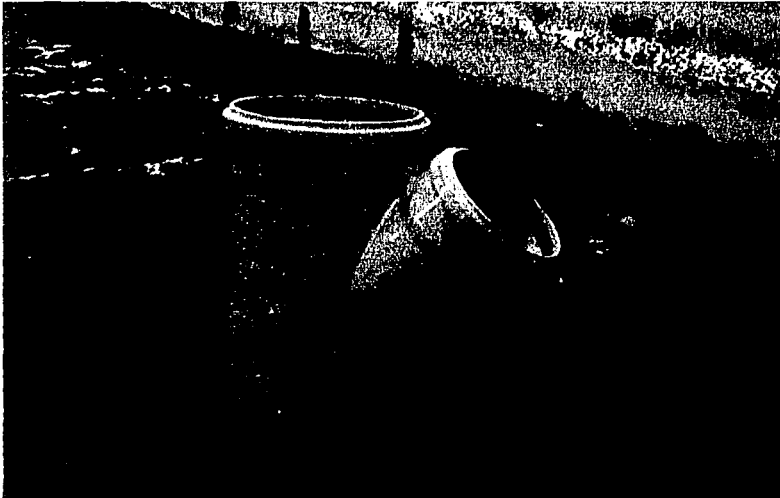
Fotografía No. 2 YEE permite mayor flexibilidad en el entronque, pero se requiere cortar las atarjeas en lugares precisos
