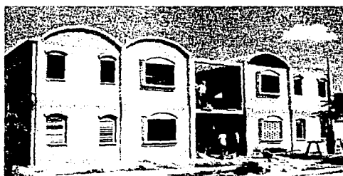
Etapa constructiva con geoblock.
